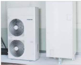
Category1 小規模施設 小型ヒートポンプ給湯器
